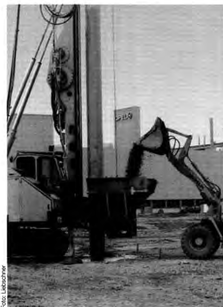
Tiefbau: Die ersten Stützen sind gesetzt
