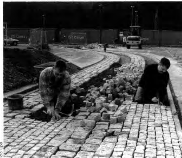
Kopf-Arbeit: In Eisenach entsteht aus Pflastersteinen eine Marterstrecke
